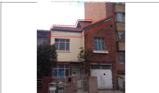
Fotografía 2 – Sobre la fachada y desde el exterior del inmueble se observa el cambio de material original de la cubierta, la elevación de una sección de la cubierta hacia el interior del inmueble, y la elevación en altura del inmueble. Intervenciones que no contaron con aprobación emitida por parte del IDPC ni de la respectiva emisión de una licencia de construcción (Fecha de toma de la imagen 06 de septiembre de 2022).
